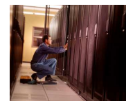
Сетевой инженер • Настройка • Отображение • И т.д..
